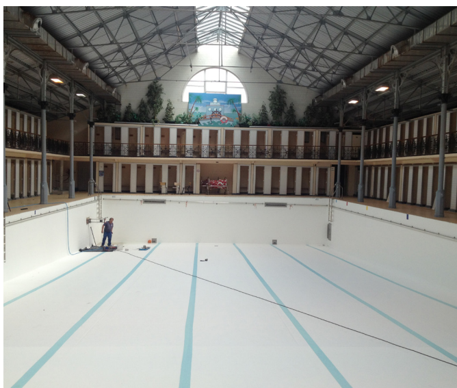
Het zwembad van Elsene tijdens de renovatiewerkn (Foto AAC Architecture)
